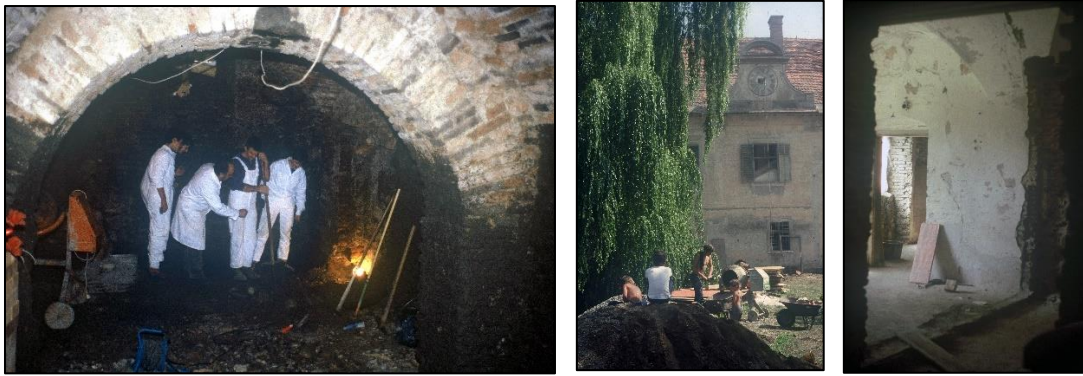
Abb. 33-35: Schlössl, Kellergewölbe. Sanierungsarbeiten. Im Schlössl. 484
