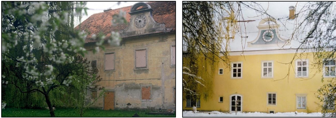
Abb. 36-37: Schlössl vor der Außenrenovierung. Schlössl nach der Außenrenovierung. 487
