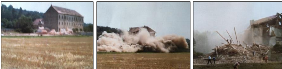
Abb. 28-30: Sprengung (1) des dreistöckigen Gebäudes. Sprengung (2). Abgetragene Gebäudeteile. 471
