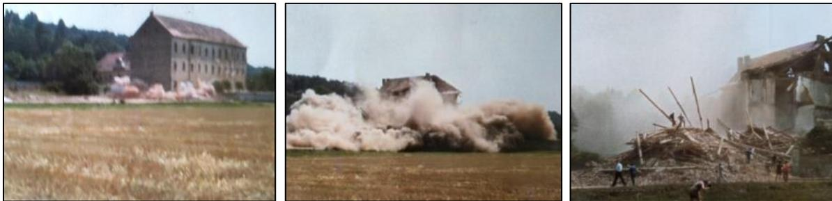
Abb. 23-25: Sprengung (1) des dreistöckigen Gebäudes. Sprengung (2). Abgetragene Gebäudeteile.<sup>464</sup>
