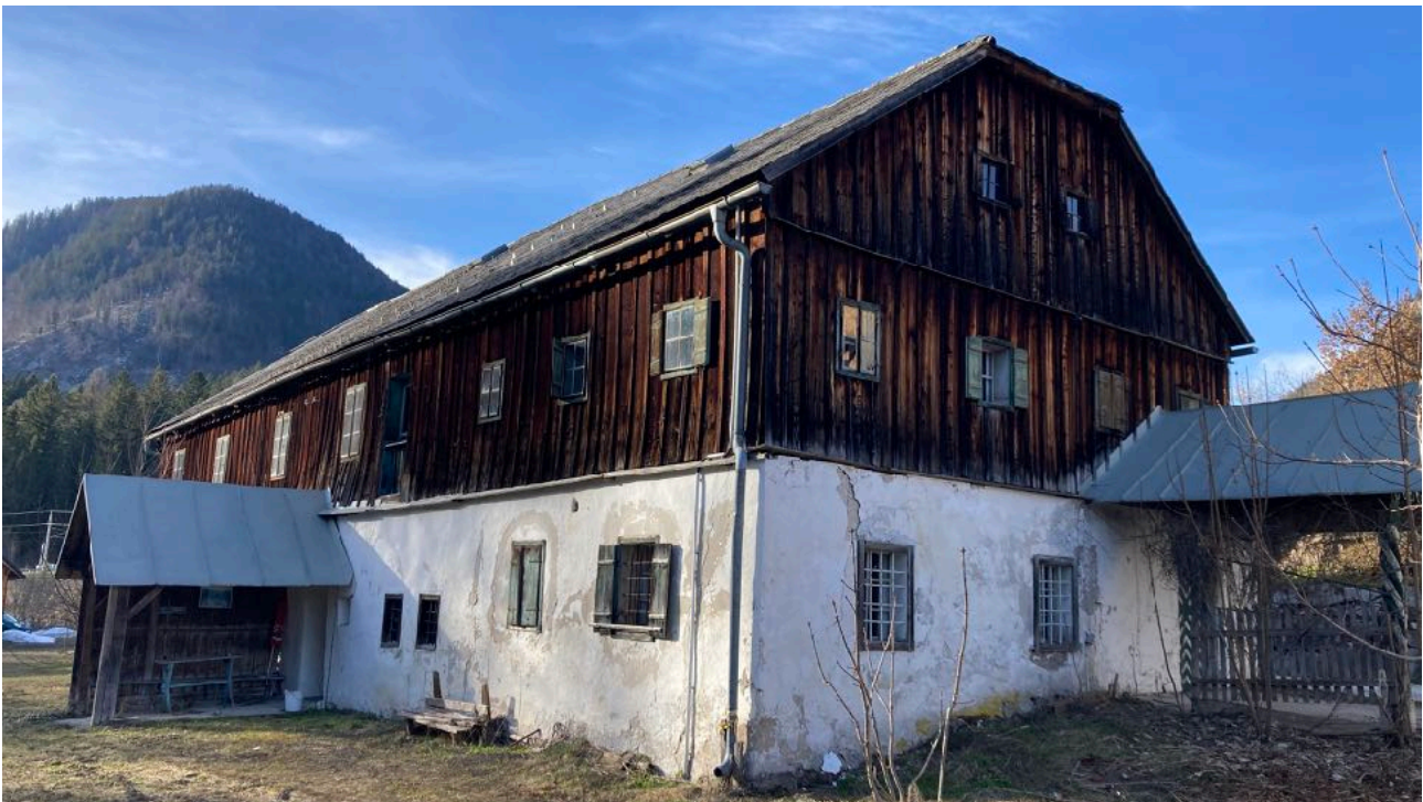
Die Oberaschermühle heute (Quelle: eigene Aufnahme)
