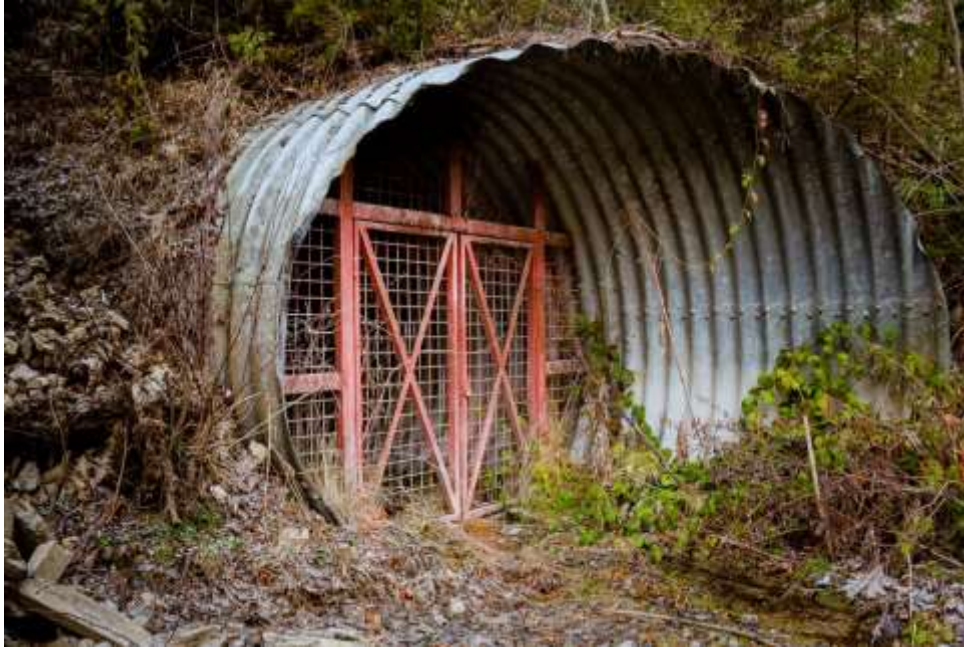
Abbildung 16: Mundlochzimmer des Silberberg-Explorationsstollen Foto: KUNZFELD, Arpad, Fotoarchiv kunzfeld & kunzfeld, 2013-01-13, Bild 3494
