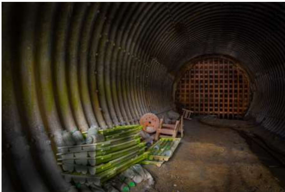
Abbildung 17: Mundlochbereich des Silberberg-Explorationsstollens 2015, Foto: KUNZFELD, Arpad, Fotoarchiv kunzfeld & kunzfeld, 2013-01-13, Bild 3528
