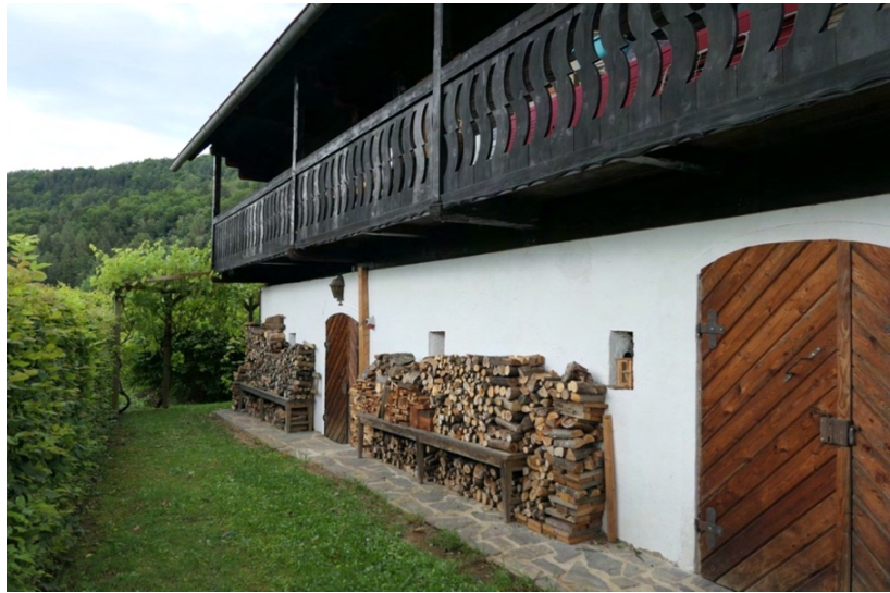
Abb.10: Konradsima-Weingartkeusche Kellersseite (Osten)
