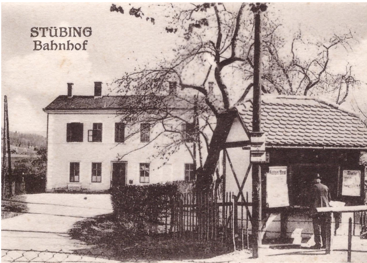
Abbildung 16: Ausschnitt aus einer Ansichtskarte, Station Stübing von der Straßenseite aus gesehen mit Kiosk. Datierung unbek.
